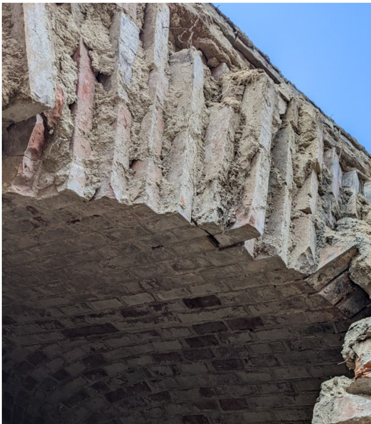
Fot. 7. Zniszczenia ściany kaponiera, u szczytu sklepienia widoczny skośny łęk otworu wentylacyjnego
