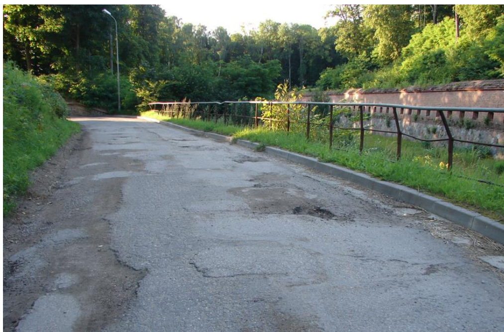
Fot. 15. Droga używana przez samochody ciężarowe na stropach kaponiery, stan przed awarią
