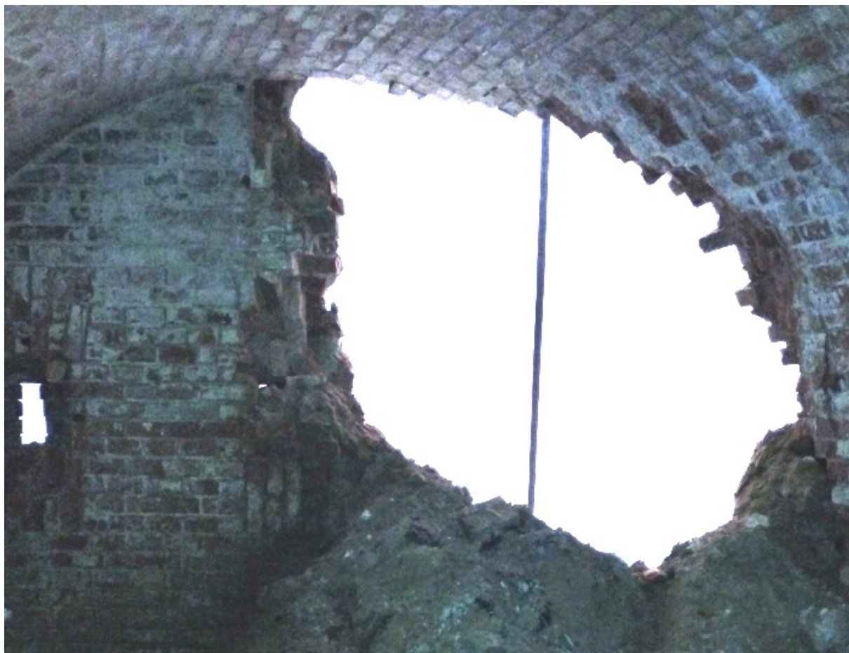
Fot.11 Zniszczenia ściany kaponiery
