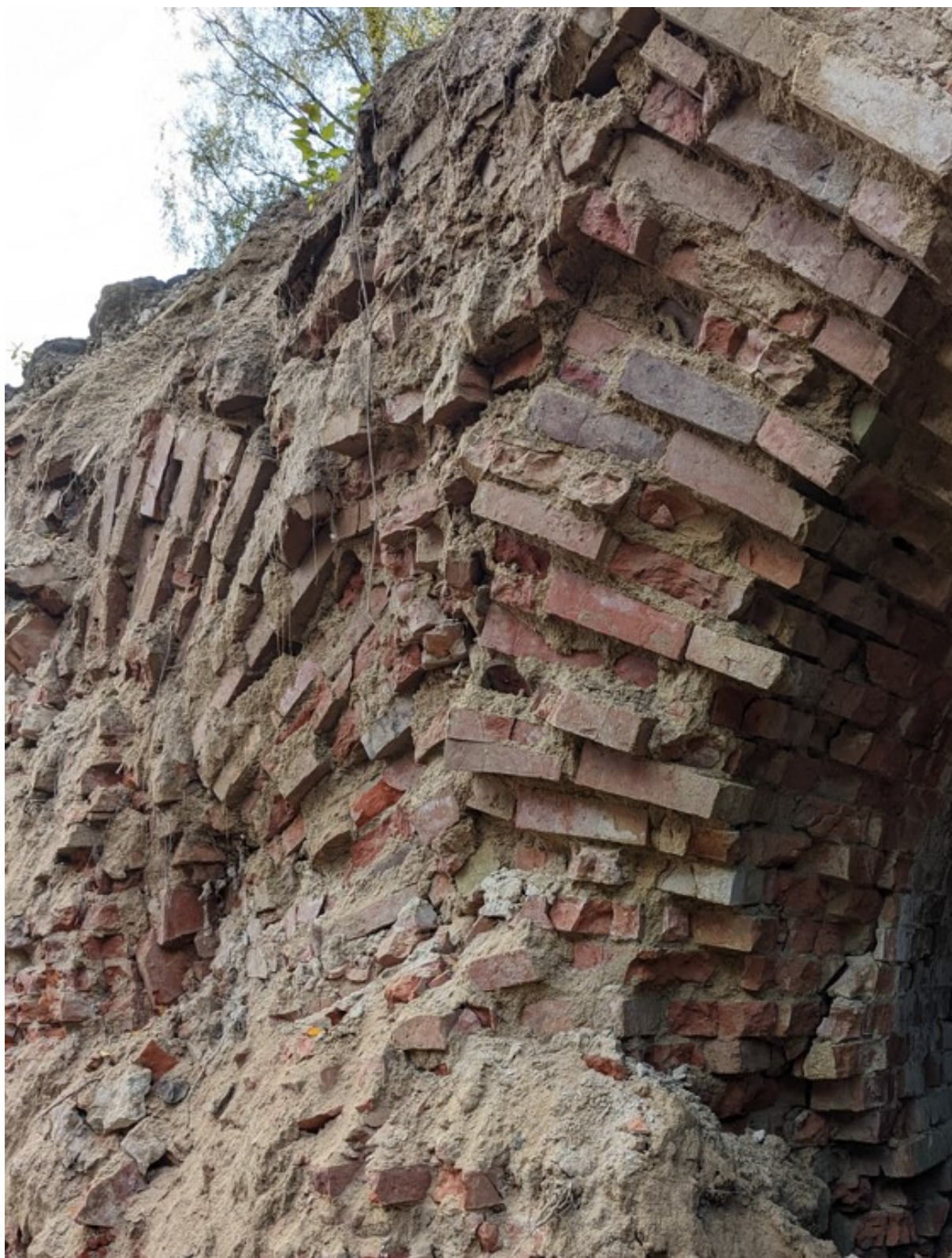
Fot. 8. Zniszczenia ściany kaponiery, widoczne murowane wypełnienie pachy między kolebkami.
