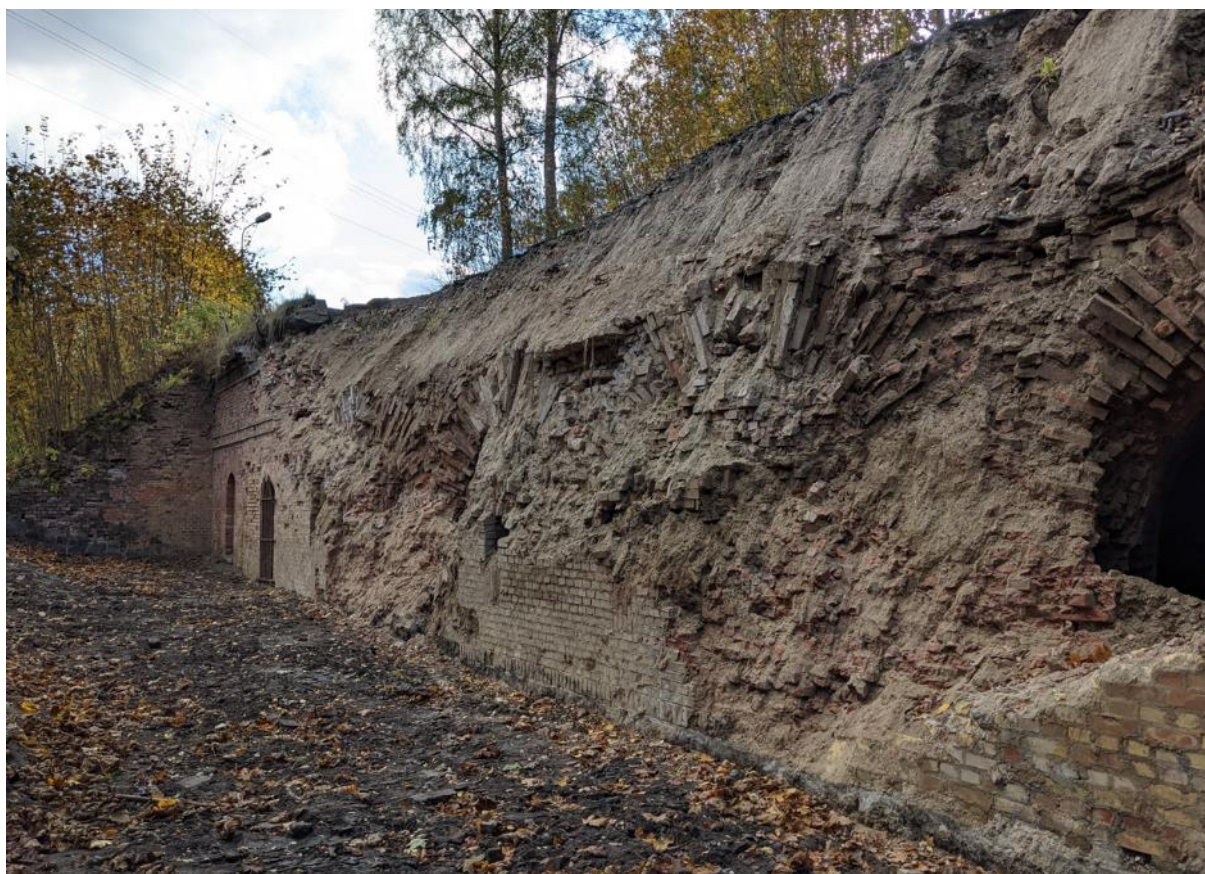
Fot.9 Zniszczenia ściany kaponiera
