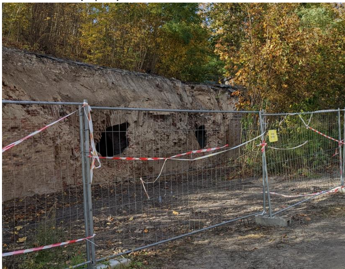
Fot. 10. Zniszczenia ściany kaponiera
