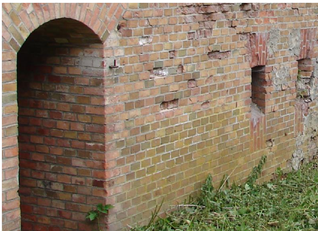
Fot.2 Wiązanie główkowe lica muru, nadproża - łuk odcinkowy, parapet rębem z cegły docinanej
