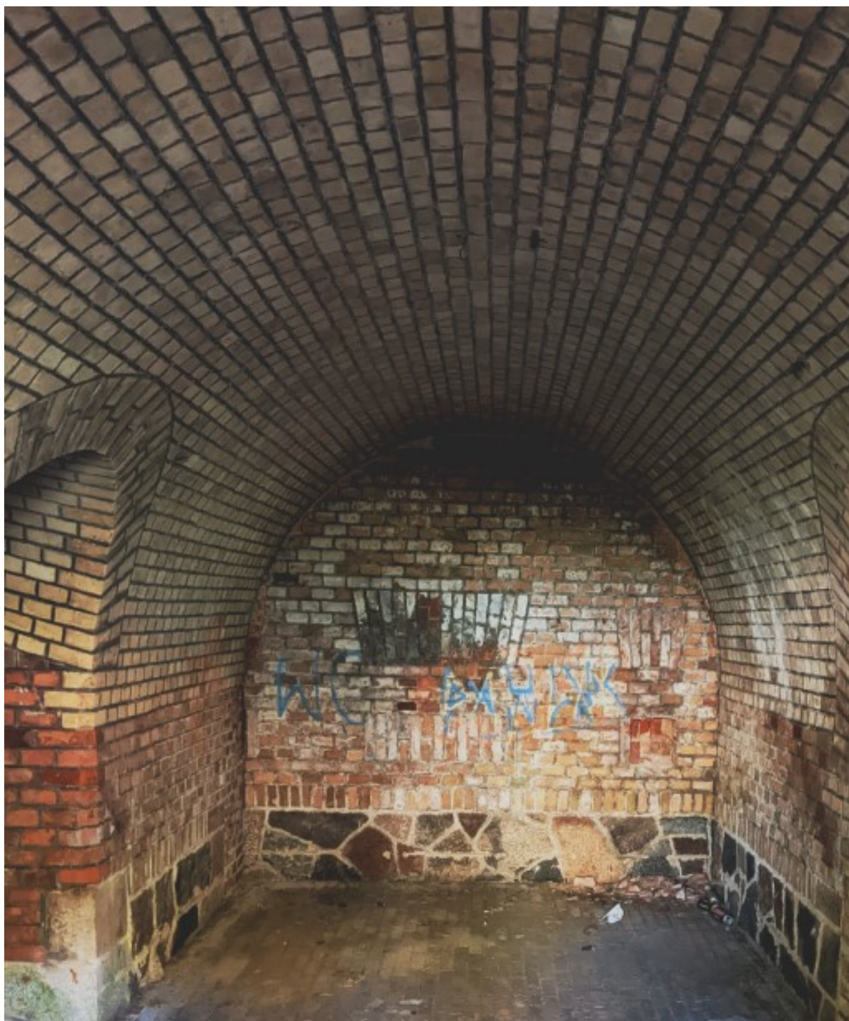
Fot.14 Wiązanie pospolite posadzki i sklepień półkolistych kolebkowych kaponiery; widać lunety wejść
