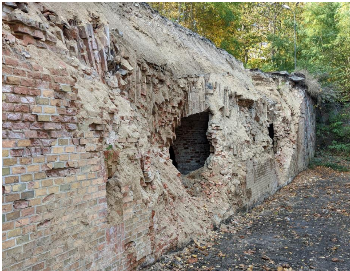
Fot. 6. Zniszczenia, w miejscach późniejszych замуrowań, ściany kaponiery
