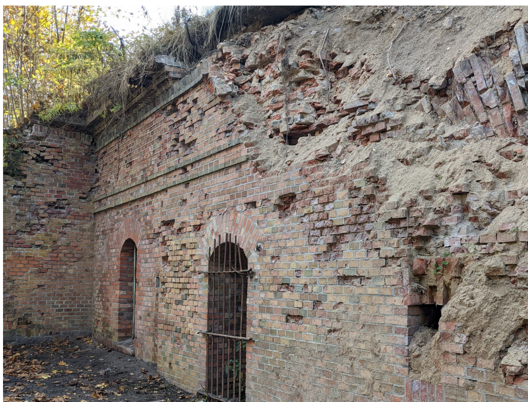
Fot.16 Ściana po awarii; widoczny zachowany fragment gzymsu (do odtworzenia)
