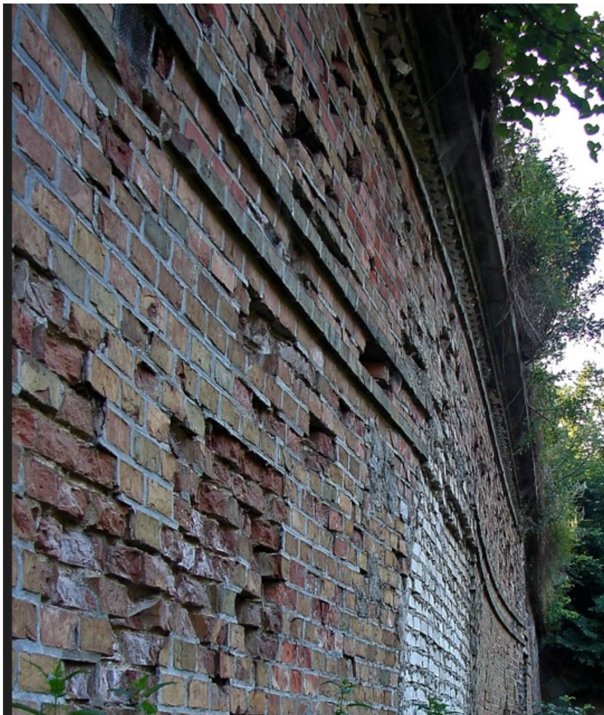
Fot. 5. Ściana kaponiera, która uległa wyboczeniu (widoczne wybrzuszenia ściany)
