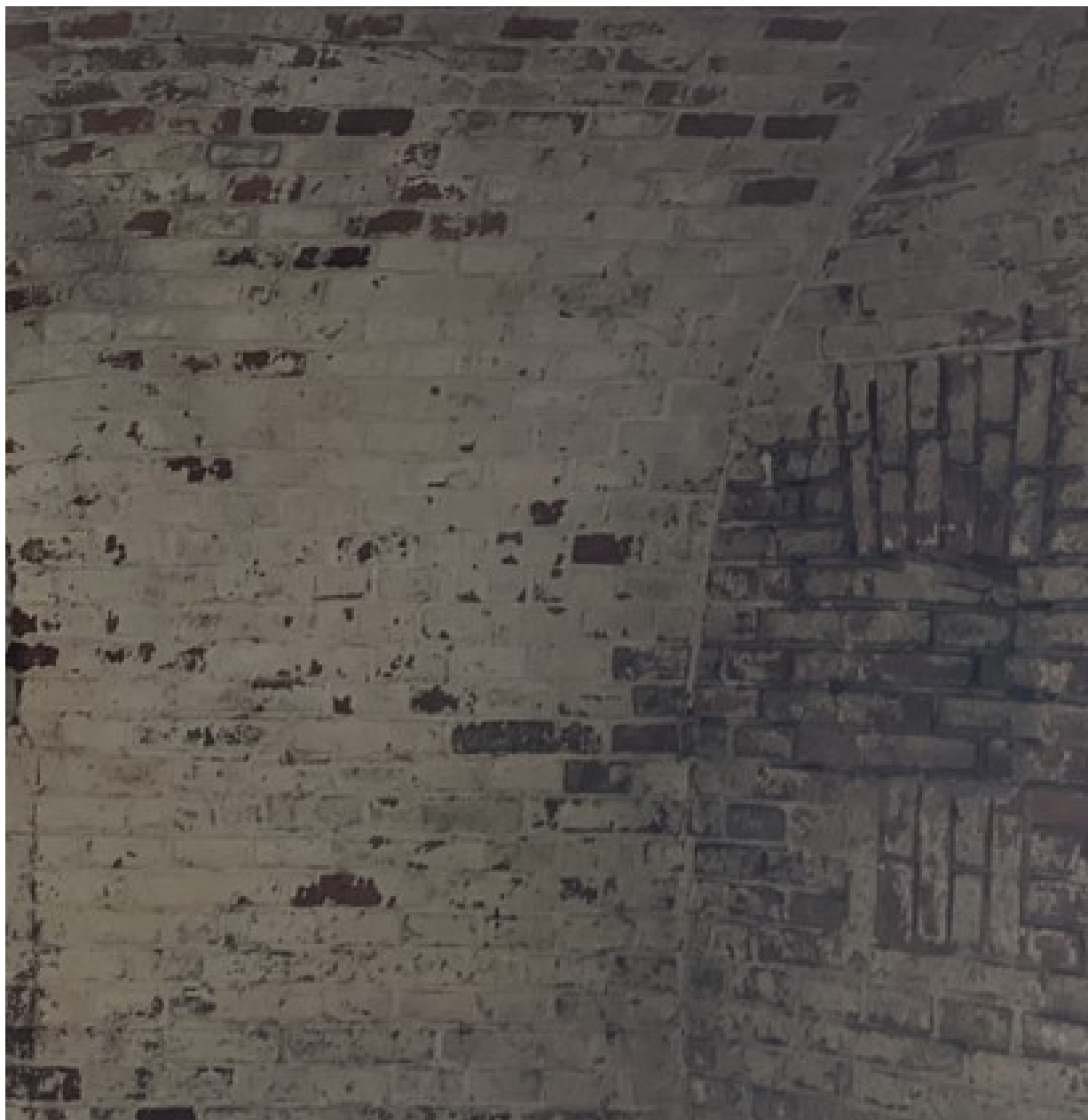
Fot.4 Zamurowane otwory kaponiery, lico wewnętrzne białkowane.
